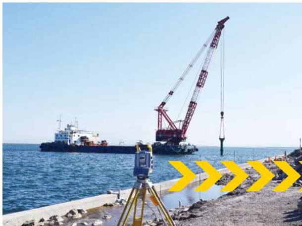
▲ 2号機(マリスタンプ工法)施工実績:境港外港中野地区岸壁(-12m)築造工事
